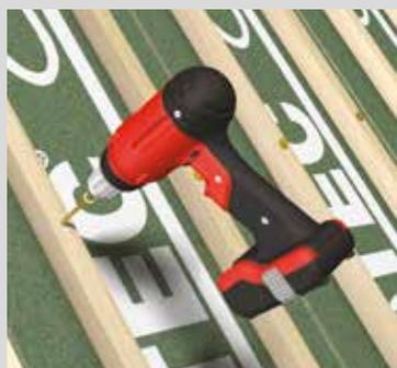
**Efivis SF** : par vissage au travers de la contrelettre avec ancrage de 50 mm, dans les pannes supports.
