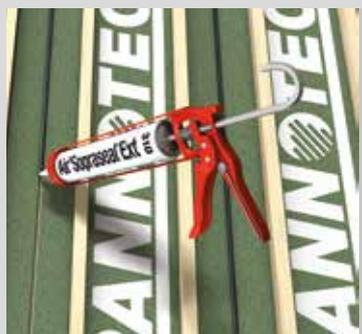
Le traitement des joints se fait par cordon continu de mastic, **Air'Soprased® Ext**, dans le chanfrein des panneaux.
