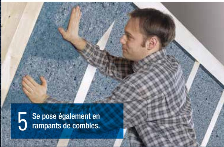
**5** Se pose également en rampants de combles.
