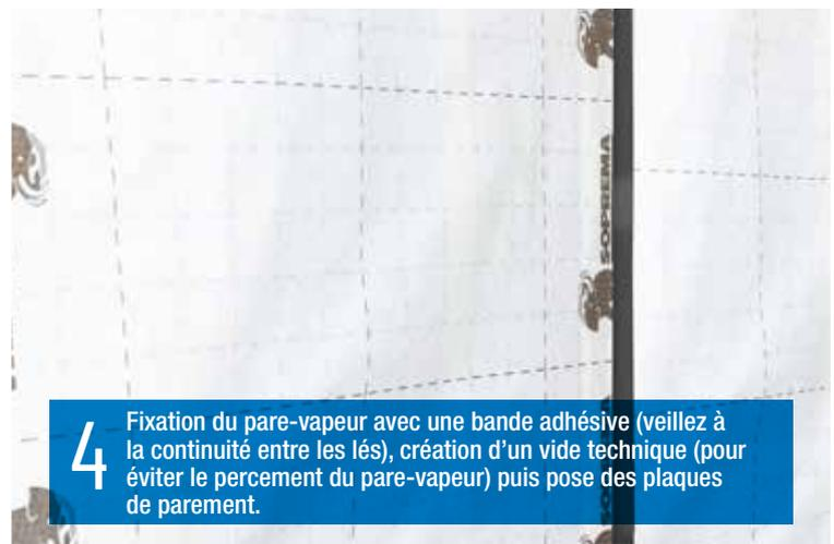
**4** Fixation du pare-vapeur avec une bande adhésive (veillez à la continuité entre les lés), création d'un vide technique (pour éviter le percement du pare-vapeur) puis pose des plaques de parement.
