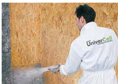
La projection humide consiste à appliquer sous pression les fibres, associées à une faible quantité d'eau pour l'isolation d'une paroi verticale.
