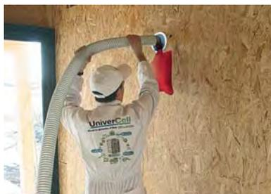
L'insufflation consiste à injecter à l'aide d'une machine pneumatique sous pression et à sec les fibres dans une paroi verticale.
