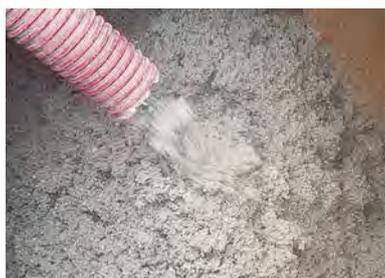
Le soufflage consiste à épandre à l'aide d'une machine pneumatique et à sec les fibres sur une surface horizontale ouverte, notamment dans les combles non aménagés.
