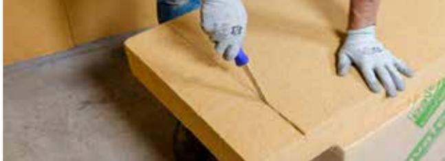
La découpe des panneaux s'effectue avec un couteau adapté pour isolants fibres de bois type **Pavacut®**.
