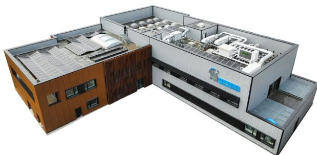
Le bâtiment démonstrateur de Saint-Julien-Du-Sault rassemble de nombreuses technologies **SOPREMA** : isolation thermique, toitures végétalisées, ventilation naturelle...
